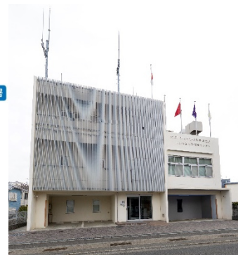
県央東部消防指令センター外観
