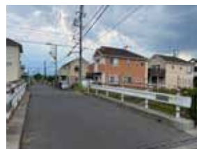
②地域の古道・鮎の道にかかる「鮎の大橋」
