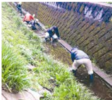
水路を清掃する様子
