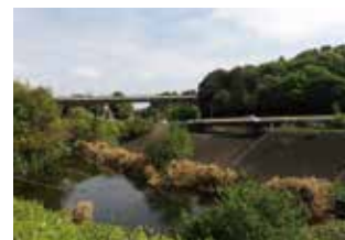
②小池大橋と栗原遊水地、目久尻川の越流堤
