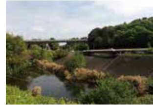
②小池大橋と栗原遊水地、目久尻川の越流堤
