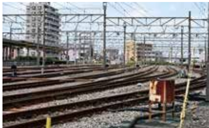
②現地写真(相武台前駅付近の引込線)
