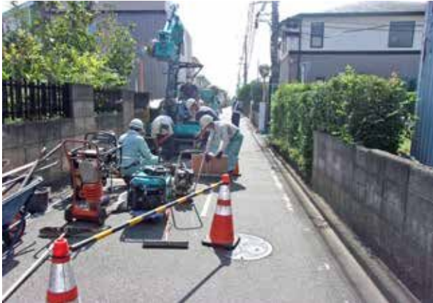
地点A (立会調査通番:1当時、北側から撮影)
