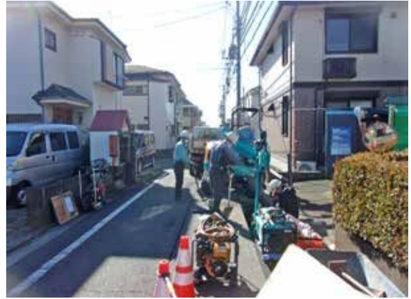
地点C—D間 (立会調査通番:8当時、北側から撮影)
