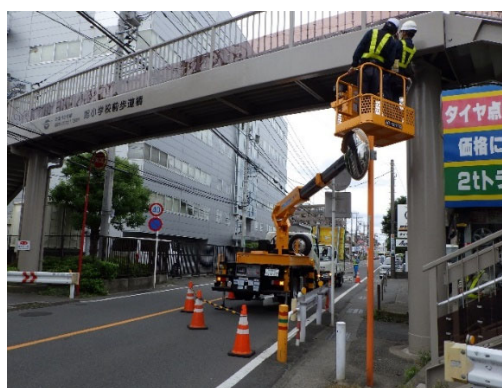
写真 6－1 横断歩道橋の点検状況
