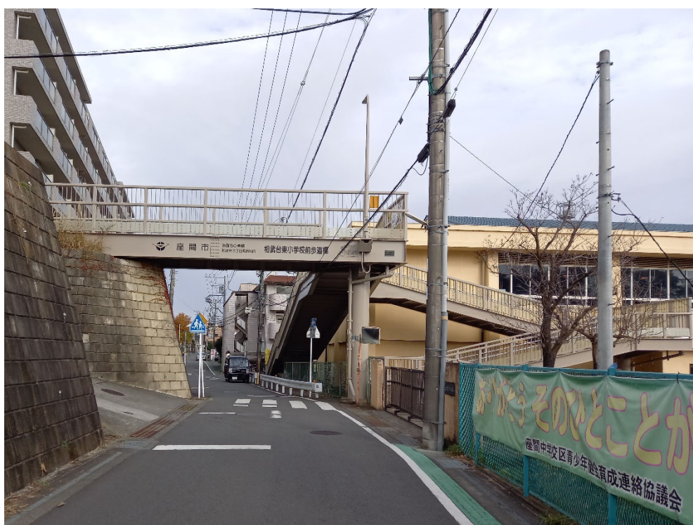
(写真：相武台東小学校前歩道橋)
