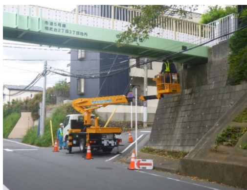
写真 6－1 横断歩道橋の点検状況
