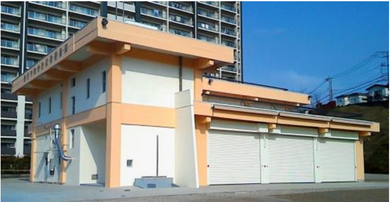
座間市総合防災備蓄倉庫
