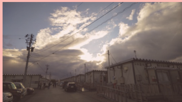
2024/1 能登半島地震仮設住宅（門前町）
