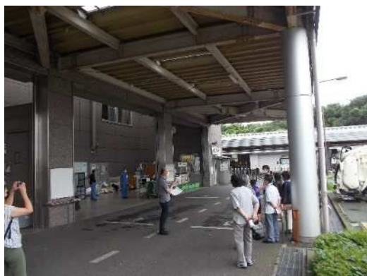
綾瀬市リサイクルプラザ
