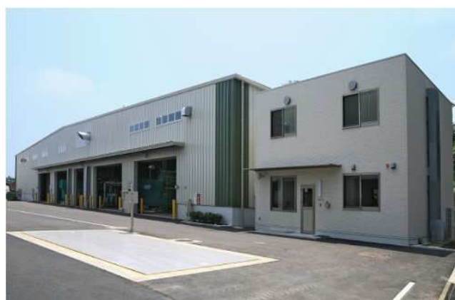
海老名市資源化センター
