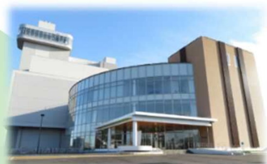
高座クリーンセンター
