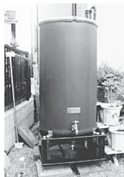
雨水貯留槽
