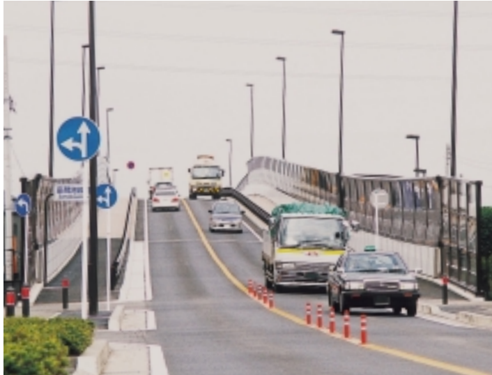
完成した座間跨線橋 (15.7 座間1丁目付近)
