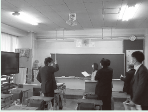
学校内の老朽箇所の説明を受けました。
