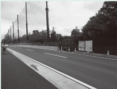
整備が進む市道7号線
