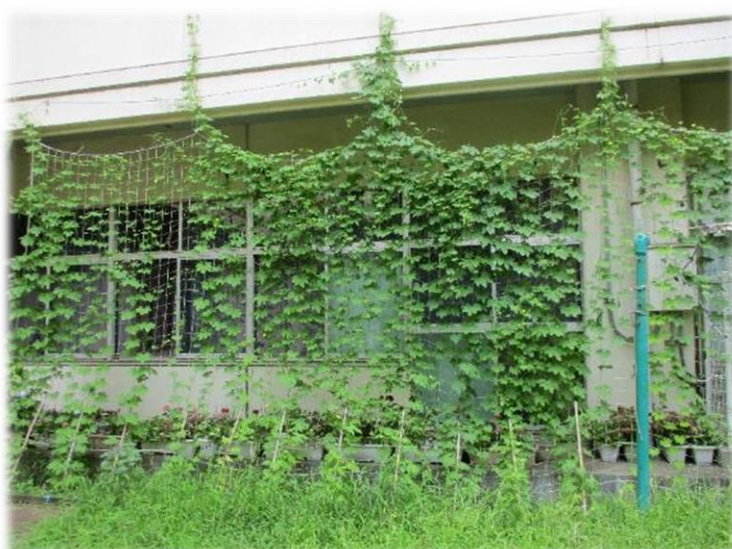
学校に設置されているグリーンカーテン
