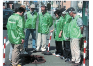
マンホールの開閉訓練
