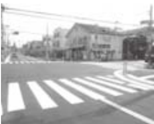
整備された市道13号線と市道14号線の交差点付近
