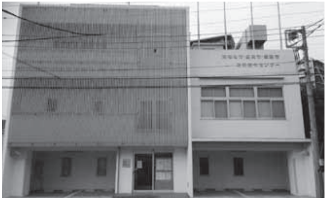
かしわ台駅前に建設された消防指令センター
