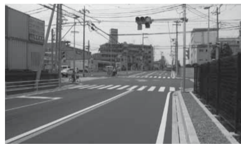
整備された市道11号線と13号線の交差点付近
