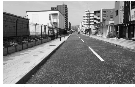
昨年整備した相武台前駅南口の前を通る市道5号線
