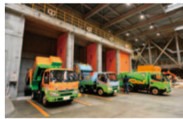
プラットホーム
