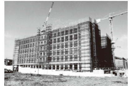
建設中の市庁舎(平成5年)
