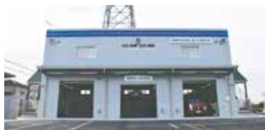
器具置場・水防倉庫建物全体
