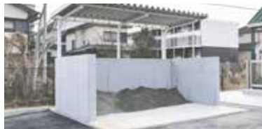
土のう作成用砂置場
