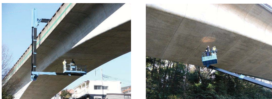
写真6-1 橋りょう点検状況
