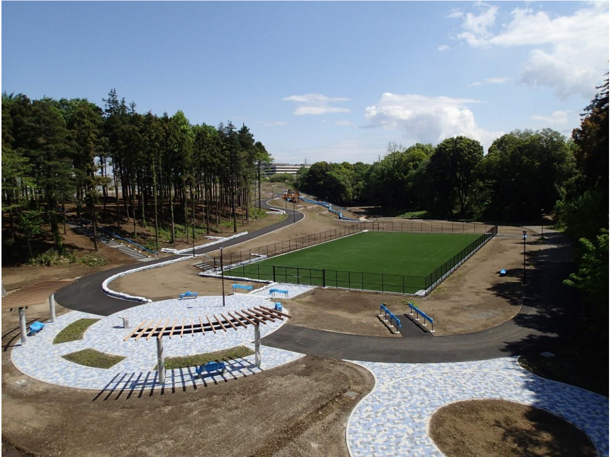
芹沢公園 北側【平成 29 年 3 月全園開園】
