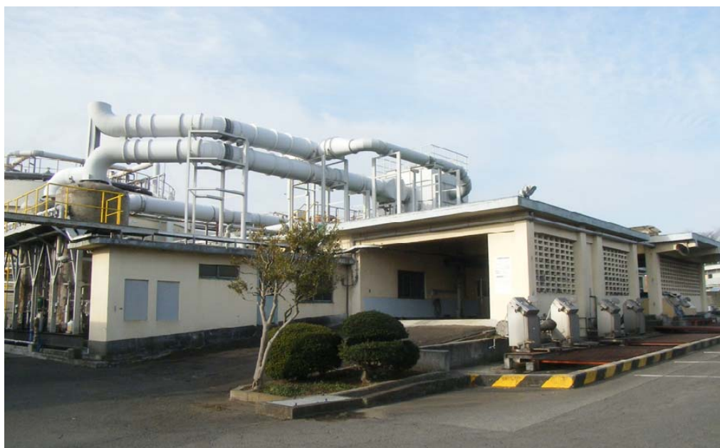
高座清掃施設組合／し尿処理施設
