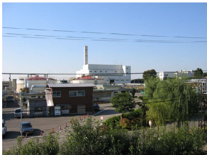
高座清掃施設組合／全景
