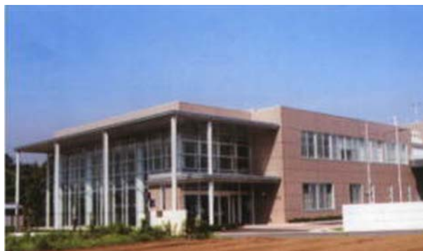
綾瀬市リサイクルプラザ
