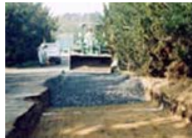
スラグの有効利用先例 路盤材(溶融エコスラグ)
