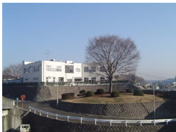
高座清掃施設組合／事務棟
