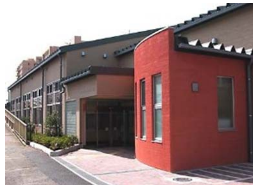
座間市リサイクルプラザ
