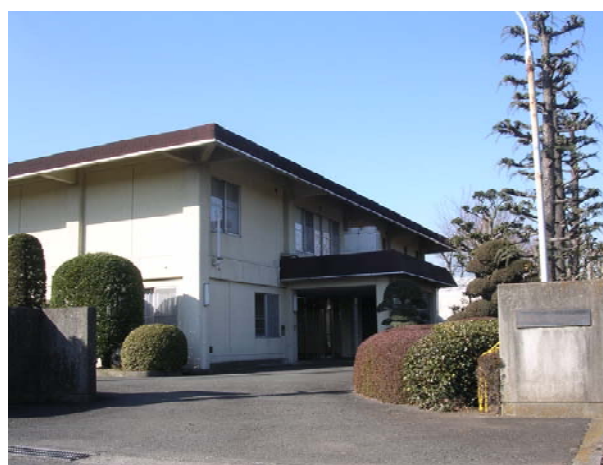
高座清掃施設組合／本郷老人福祉センター (焼却余熱利用施設)
