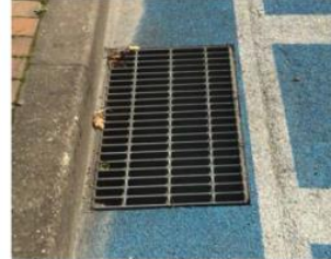
事例-2 グレーチング蓋格子の形状等を工夫した事例
