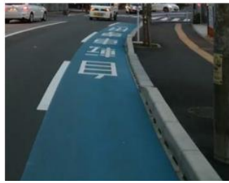
事例-1 街渠をエプロン幅の狭い平坦性の高いものに置き換えた事例
