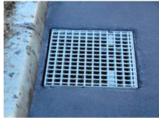
事例-2 グレーチング蓋格子の形状等を工夫した事例
