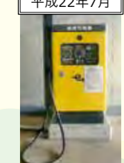
電気自動車用急速充電設備設置
