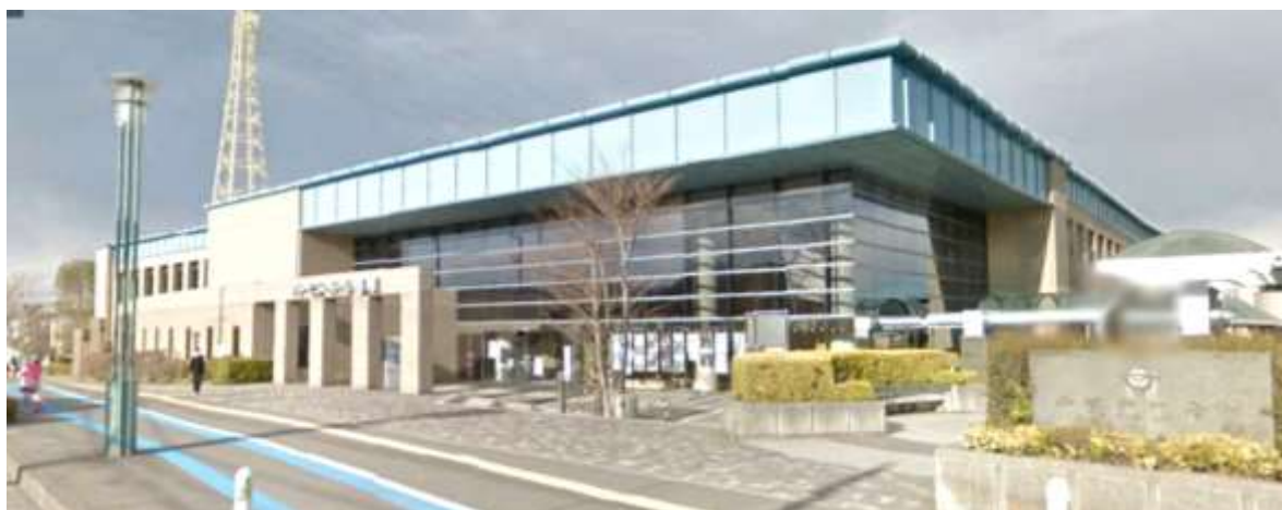
市民文化会館（ハーモニーホール座間）
