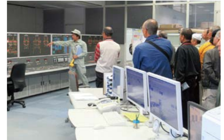
市上水施設、県下水処理施設等（環境部）
