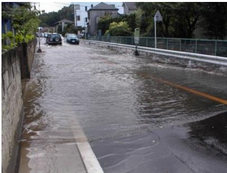
目久尻川・相模台雨水幹線整備前
