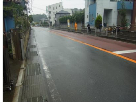
現在（目久尻川・相模台雨水幹線整備後）
