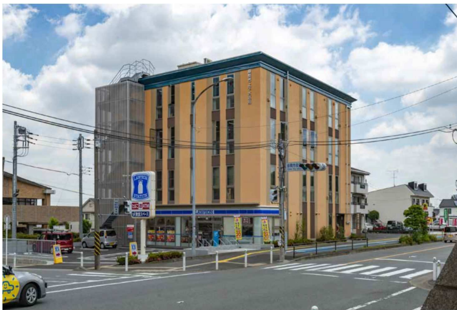
写真 上下水道局庁舎
