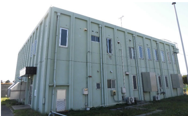
写真 四ツ谷配水管理所（左）
