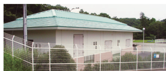
羽根沢受水場
