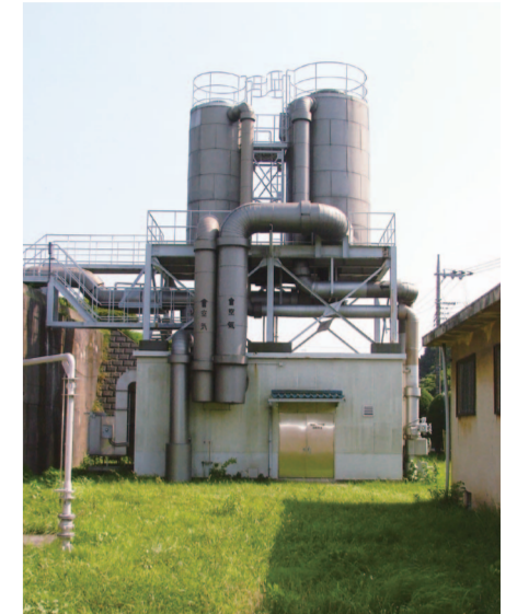
第2配水場の有機塩素化合物(トリクロロエチレン)除去装置及び減菌室
