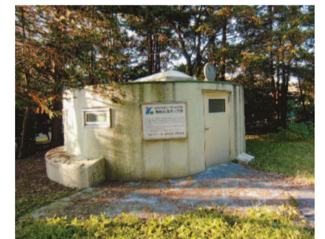
栗原水源ポンプ所
