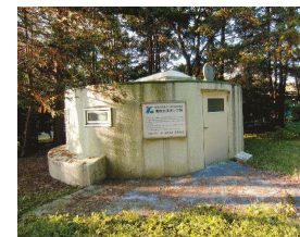
栗原水源ポンプ所
