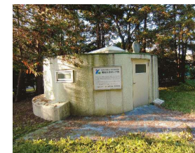
東原水源ポンプ所
