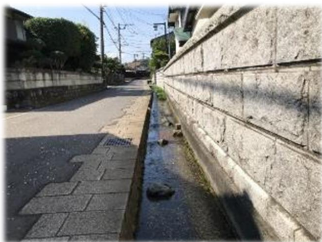
鈴鹿長宿の水路の様子（令和2年8月撮影）
