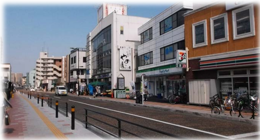
市道5号線（平成27年4月撮影）
