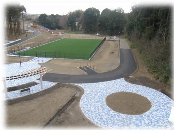
整備工事中の芹沢公園の様子
